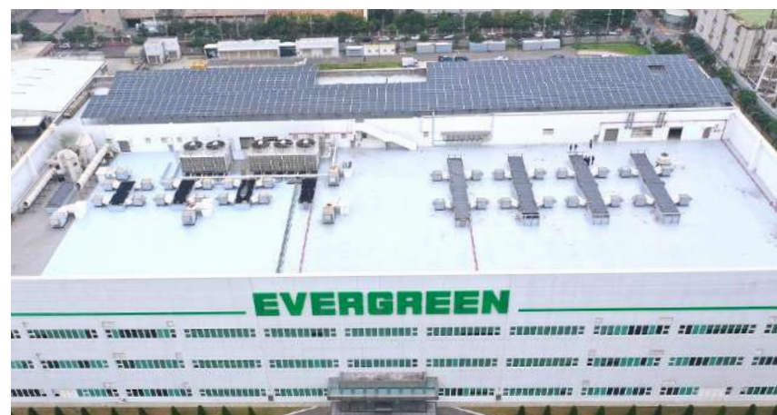
製造廠房屋頂建置太陽能發電系統
